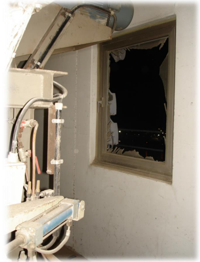
Fenster im 12. OG
