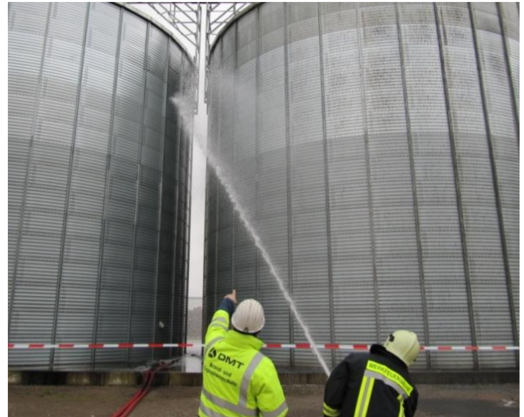
Kühlung mittels Monitor
